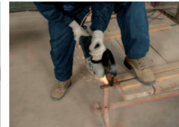
Quando utilizzi il flessibile assicurati che l'area di lavoro sia pulita, sgombrata da materiali e utensili. Mantieni una distanza adeguata da chi ti sta attorno. Non usare il flessibile su piani instabili, ad esempio su scale. Stai attento a non danneggiare, con le scorie incandescenti, oggetti o materiali vicini (vetri, piastrelle o altro).
