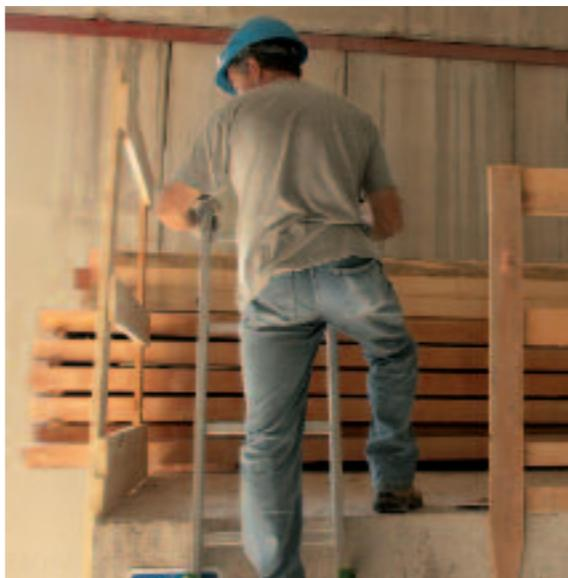
Dove è possibile assicurati che la scala sia ancorata all'arrivo. Nel dubbio chiedi a un collega di tener ferma la base. Al piano di arrivo la scala deve sporgere in modo sufficiente in modo da facilitare sbarco e discesa.
