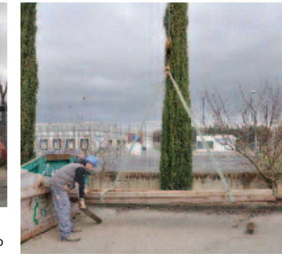
In attesa del carico da depositare, prepara delle traversine di legno (vedi fotografia) per facilitare la posa del materiale. Dopo la posa del carico, attendi il segnale del gruista per sganciarlo, infine toglì l'imbracatura facendo attenzione a non disperdere il materiale. Fai sempre attenzione al bozzello.
