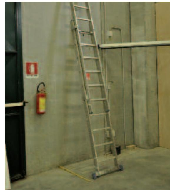
La scala deve avere una pendenza adeguata:  $\frac{1}{4}$  dell'altezza. Esempio: una scala di 4 metri alla base deve avere 1 metro di distanza dal muro.
