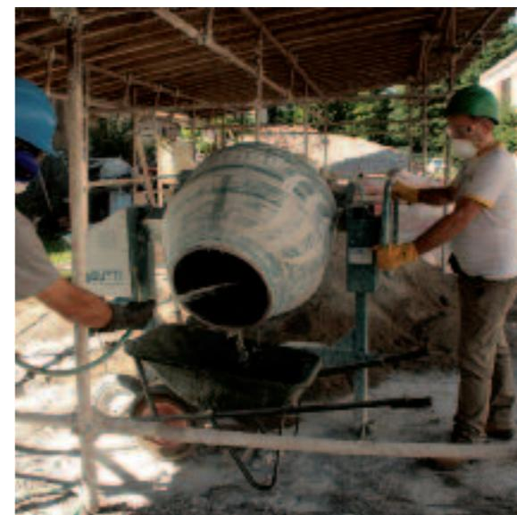
A svuotamento effettuato lava accuratamente la betoniera avendo cura di non bagnare il quadro elettrico.
