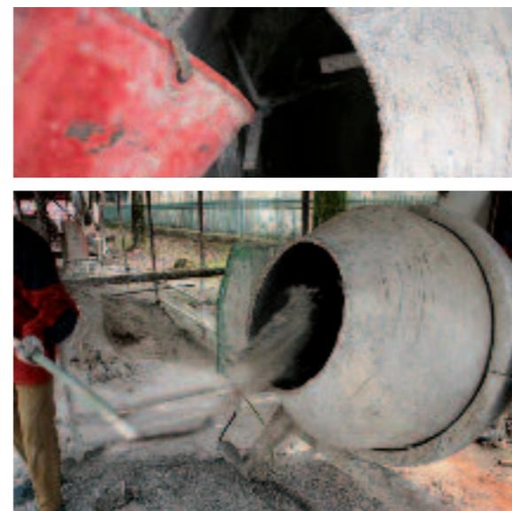
Procedi con il caricamento: metti prima l'acqua e poi con il badile getta il materiale (sabbia o altro) dentro la bocca della betoniera.
