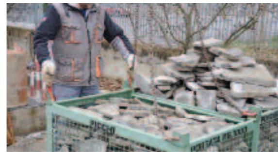
Metti i guanti e controlla che catene e fasce siano in buono stato: le fasce non devono essere tagliate o strappate, le catene non devono essere deformate e i ganci devono avere la chiusura a molla funzionante. Segnala sempre al gruista eventuali problemi, in modo che provveda alla sostituzione.
