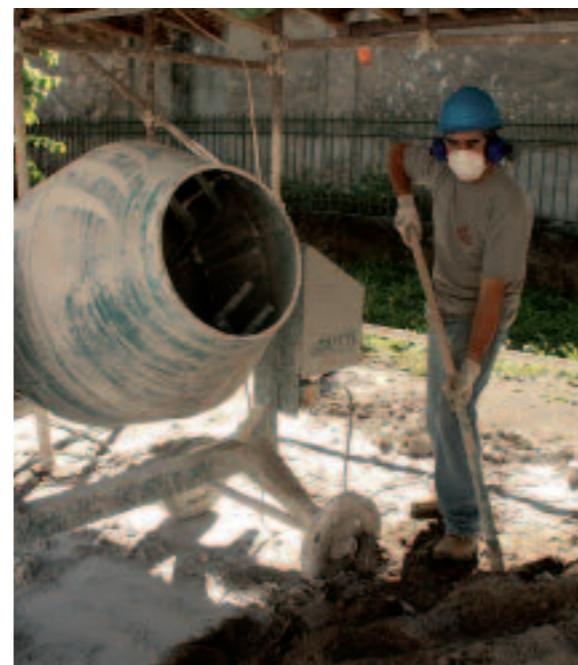
Mettiti al fianco della betoniera dalla parte opposta rispetto al del maniglione di carico e scarico. Quando lavori a betoniera avviata eviterai gli schizzi.
