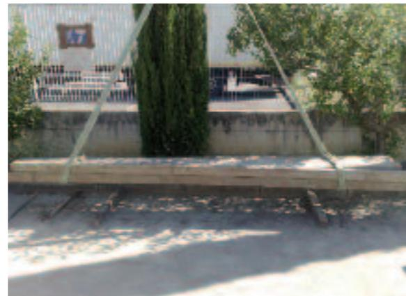
Prima di caricare o scaricare travi e tavole metti delle traversine di legno in modo da facilitare il passaggio delle fasce o delle funi.
