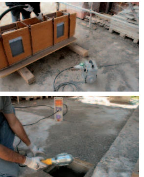
In ambienti molto umidi vanno usati utensili elettrici con voltaggio non superiore a 50 V e lampade elettriche con una tensione non superiore a 24 V.
