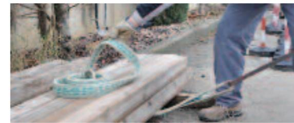
Imbraca il carico facendovi passare sotto fasce e catene, fissale a coppia, proteggi le fasce da spigoli/angoli con pezzi di legno per evitare che si taglino e controlla che siano ben distanziate. Non agganciare mai il gancio della gru al filo di ferro o alle corde che tengono unito il pacco di tavole.
