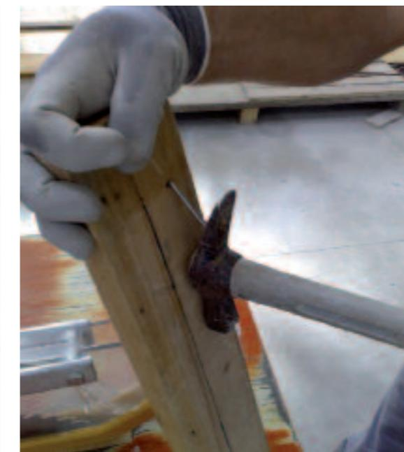
Togli i chiodi dalle tavole con la penna biforcuta (a coda di rondine) del martello da carpentiere. Deposita le tavole e altri elementi lunghi a terra, non appoggiare al muro in verticale.
