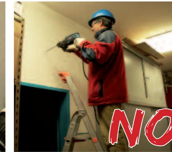
Quando utilizzi il trapano assicurati che l'area di lavoro sia pulita, sgombrata da materiali e utensili. Mantieni una distanza adeguata dagli altri operatori. Non usare il trapano su piani instabili, ad esempio su scale. Nelle pause di lavoro e alla fine stacca sempre il cavo dalla presa elettrica; non lasciare l'attrezzo incustodito in tensione.
